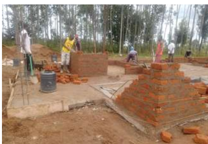
Construcción de un dormitorio de recate en Nyamotambe. Kuria JCCM Coop.
