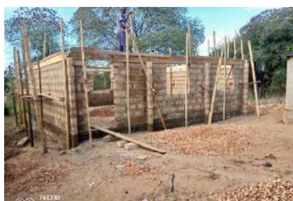
Construcción aulario especial con vallado, panel solar, letrina y tanque de agua en la escuela de primaria de Tharaka Diputación de Ciudad Real
