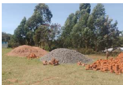
Construcción dormitorio con vallado, panel solar, letrina y tanque de agua en Bikarabwa. Kuria Comunidad de Madrid
