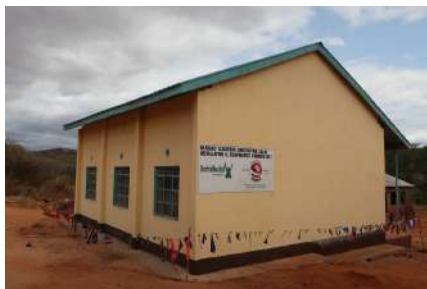
Construcción de una clase en Nkaraku en Tharaka Fundación Rafa Nadal
