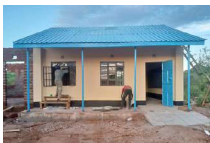
Reparación clase de Kamikau en Tharaka Ayto. Illescas
