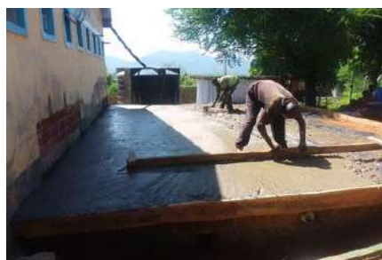
Construcción de letrina y lavandería en RH en Tharaka Diputación de Córdoba
