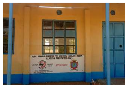
Reparación clase de Mwarangeni en Tharaka Ayto. Zumarraga
