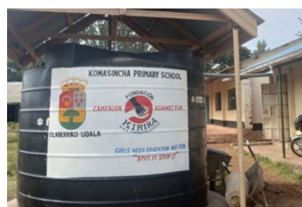
Tanque de agua en Komasincha Ayto Olaberriá
