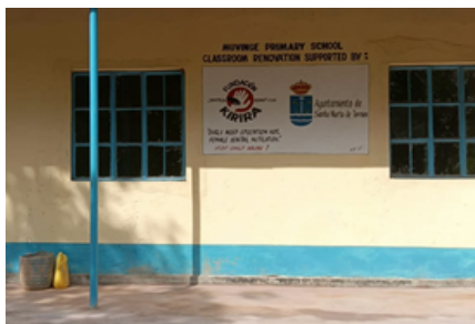
Renovación de un aula en mal estado en Muvinge Pri. Sch. Ayto Santa Marta de Tormes
