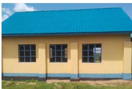
Construcción de un aulario en Escuela de Pri. Bikarabwa
