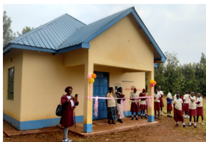
Contrucción de un dormitorio de rescate en escuela de Nyamotambe
