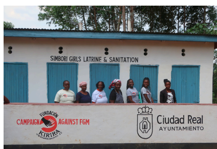
Acceso al saneamiento seguro y agua potable en Simbori Pri. Sch.
