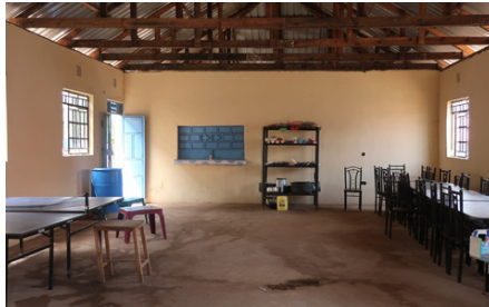
Renovación de espacios Rescue House
