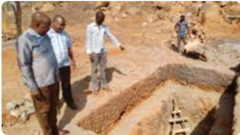
Sigue la construcción de la letrina de Gankanga
