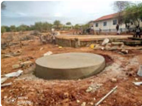
Construcción de la base de hormigón para el tanque de agua en Gankanga
