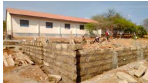
Construcción de los cimientos del dormitorio de rescate de Gankanga
