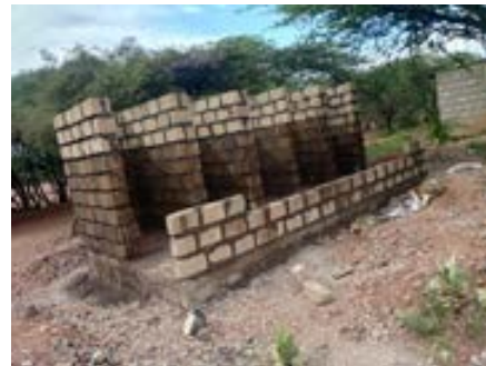
Sigue la construcción de las letrinas en Kachilitwa
