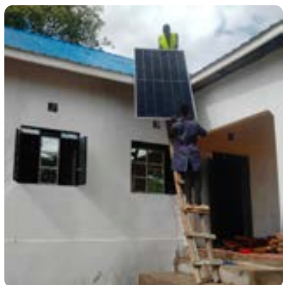
Instalación de los paneles solares en Rescue Center financiado por la JCCM
