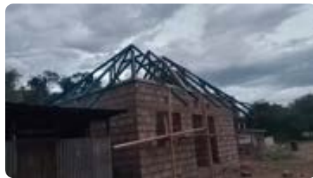
Construcción de la cocina de Chepkalacha financiada por la Diputación de Córdoba
