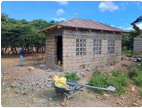
Construcción de letrinas en Kachilitwa financiado por AUARA
