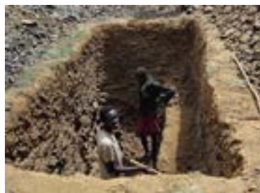
Construcción de las letrinas en Lomerimeri financiado por AUARA
